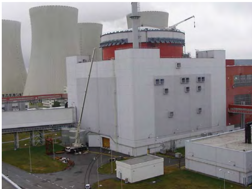
Pohled na jeden z kontejnmentů JE Temelín
