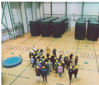
Od začátku provozu Dukovan jsme měli značně omezený přístup k informacím týkajícím se projektování a testování paliva v SSSR a zdůvodnění jeho provozních i bezpečnostních limitů - ilustrační foto
