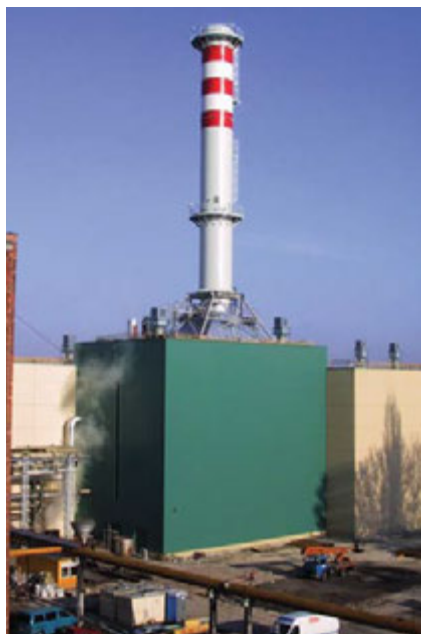
Obr. 6 – Dodávka spalinového kotle pro zákazníka v Kispesti byla jednou z řady úspěšně realizovaných projektů v Maďarsku. Vertikální jednotláký kotel s odběrem tepla pro vytápění města byl dodán v „C-ěčkových“ modulech
