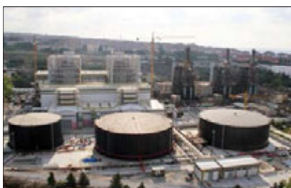
Obr. 1 – Projekt Ambarlı se nachází nedaleko mezinárodního letiště v Istanbulu. Jedná se o dva vertikální spalinové kotle za plynovou turbínu 300 MW. Zákazník požadoval možnost provozu plynové turbíny přes plně odvodněný kotel
