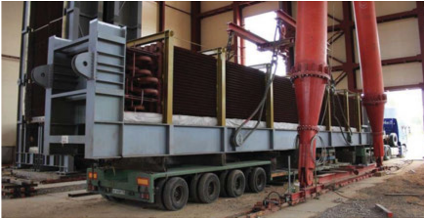
Obr. 7 – Rusko patří k našim klíčovým trhům. Ukázkou realizace je projekt Vologda montovaný na stavbě ruským zákazníkem z dodaných „C-ěčkových“ modulů horizontálního spalínového kotle
