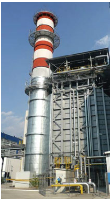
Obr. 5 – Projekt Bucuresti Vest byl mimo jiné první dodávkou nového kotle v postkomunistické éře Rumunska. Tomu odpovídala drobnohledná optika, s jakou místní orgány ke schvalování tohoto zařízení přistupovaly. Kotel je venkovního provedení s dodatečným přitápěním a byl z důvodů omezeného prostoru montážně sestavován po jednotlivých řadách výhřevných ploch až na místě
