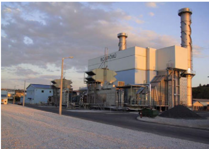
Obr. 4 – Projekt BorsodChem sestává ze dvou spalinových kotlů za plynovou turbínu 25 MW a dvou topených kotlů, které jsou trvale drženy v teplé záloze. Projekt byl dodán „na klíč“ včetně kompletní kotelny
