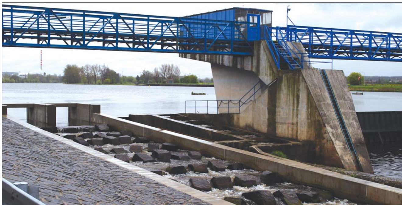
Jezevce pole u Malé vodní elektrárny Štětí, v popředí rybí přechod
