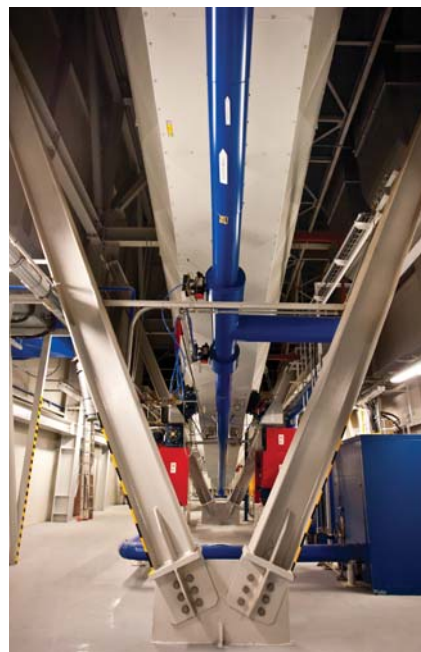
Technologické patro +9,0 metrů – průběžný fluidní žlab
