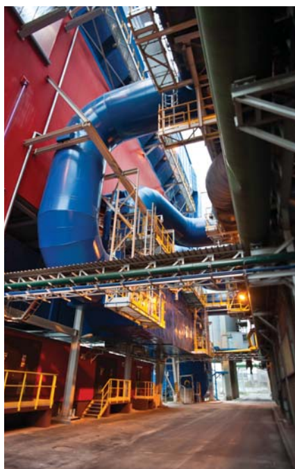
Napojení kouřovodů na technologii DeSO x
