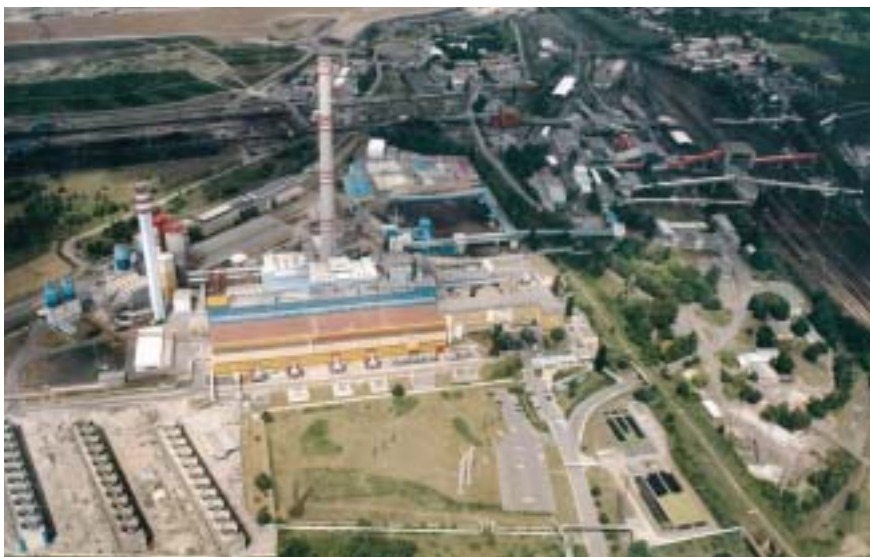
Obr. 2 – Areál Elektrárny Ledvice a dolu Bílina před rekonstrukcí
