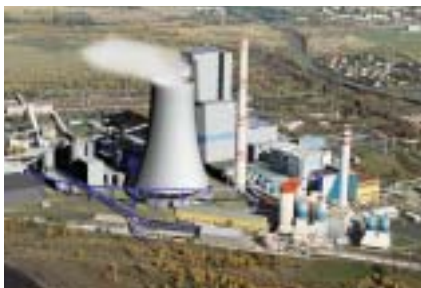
Obr. 4 – Areál Elektrárny Ledvice s vizualizací nového bloku po rekonstrukci – pohled odzadu
