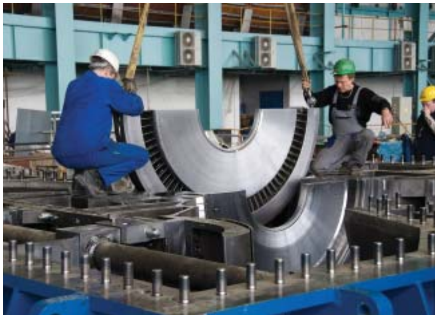
Snímek z montáže technologických zařízení
