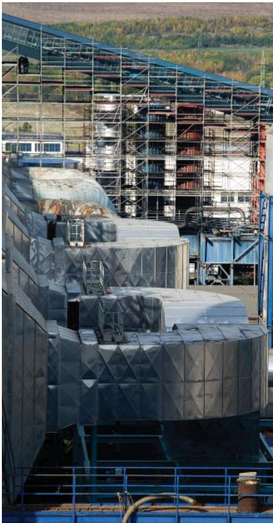
Kouřovody bloků 23 a 24 po komplexní obnově
