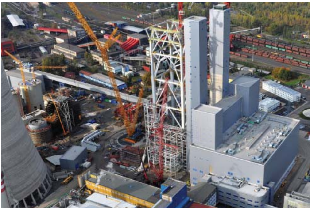
Letecký pohled na konstrukce budoucího nového zdroje
