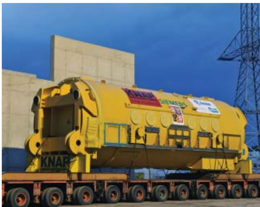
Převaha generátoru do strojovny
