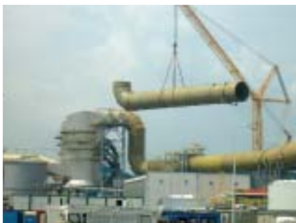
Montáž kouřovodu čistých spalin
