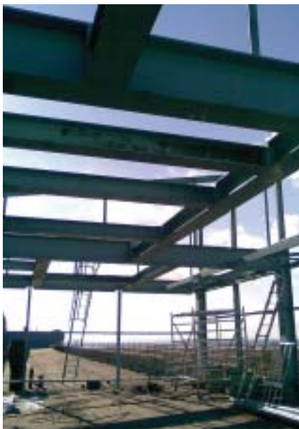
Snímek z montáže ocelových konstrukcí – ilustrační foto
