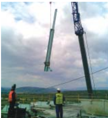
Doprava konstrukčních dílů určených k montáži zastřešení
