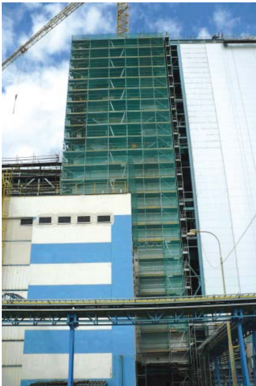
V rámci první etapy opláštění HVB bylo použito cca 15 000 m 2 lešení
