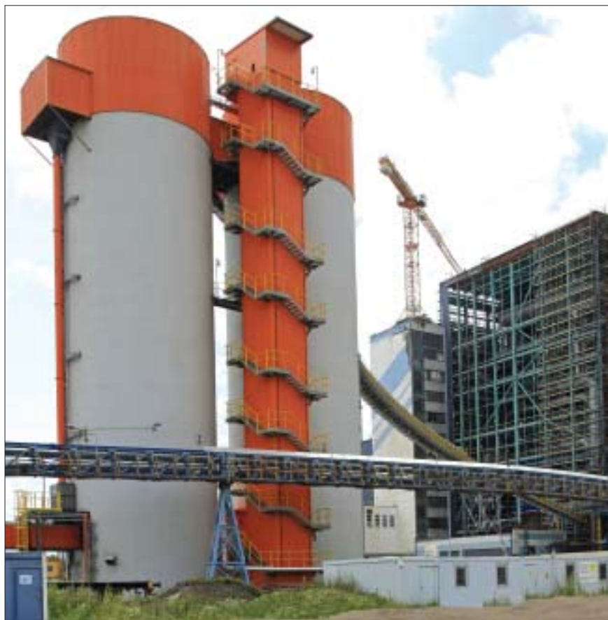
Strusková síla, vpravo demontáž východní fasády
