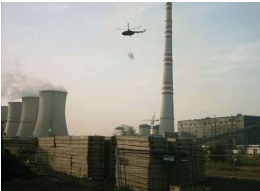
Přeprava ocelové konstrukce vrtulníkem
