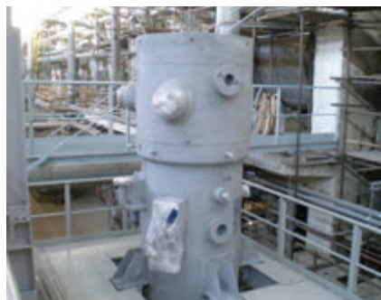
Ohřívák usazen na opěrných patkách ve vertikální poloze, vstupní a výstupní hrdla jsou ještě zaslepená, chráněná proti nežádoucímu vniku nečistot při dopravě, v horní části je umístěna vodní komora
