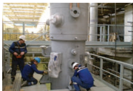
Ustavování výměníku na opěrné patky, výměník visí na dvou závěsných čepích umístěných na vodní komoře
