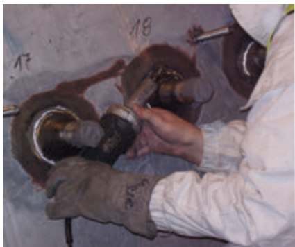
Přivařování a úprava svaru dodatečně montovaných nátrubků na PG 36
