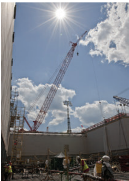
Práce uvnitř jaderného ostrova, Vogtle
