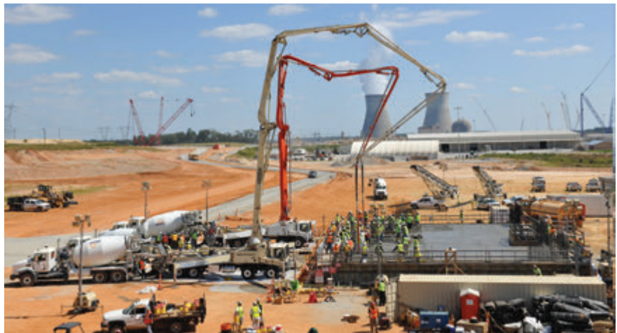
Příprava betonových základů v americkém Vogtle
