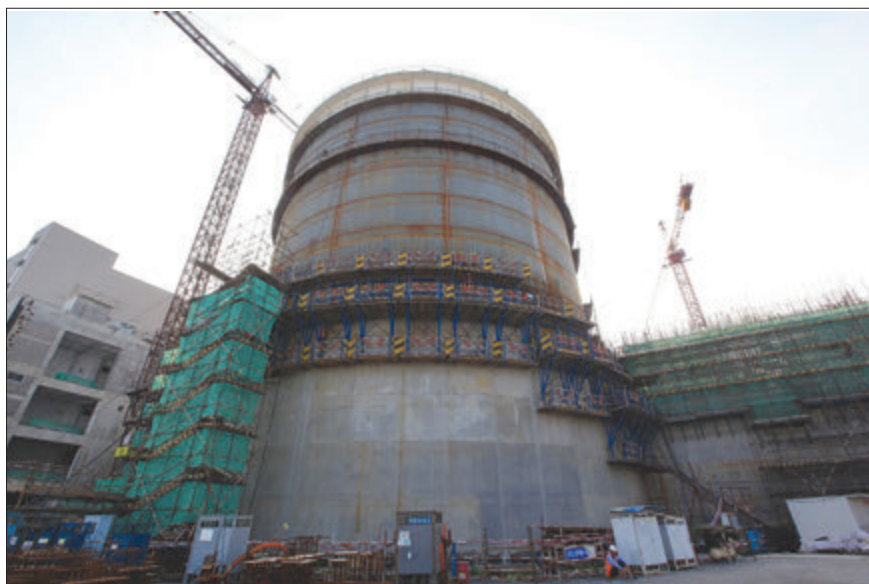
Čínský Sanmen, blok 1, kolem ocelových prstenců ochranné obálky reaktoru se vrší tuny betonu
