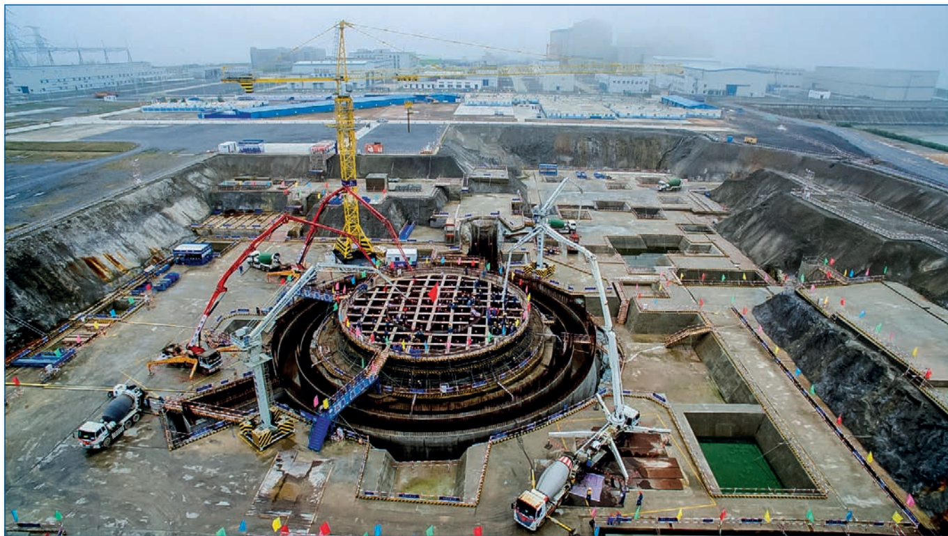
Výstavba 3. bloku čínské jaderné elektrárny Fang-čcheng-kang.
