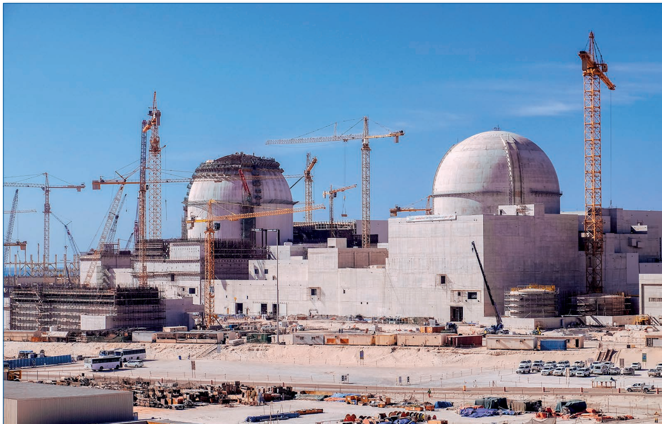
Výstavba Jaderné elektrárny Baraka
